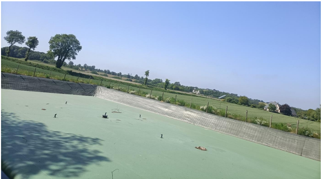
Figure 10 : installation citerne souple avec merlon de rétention
